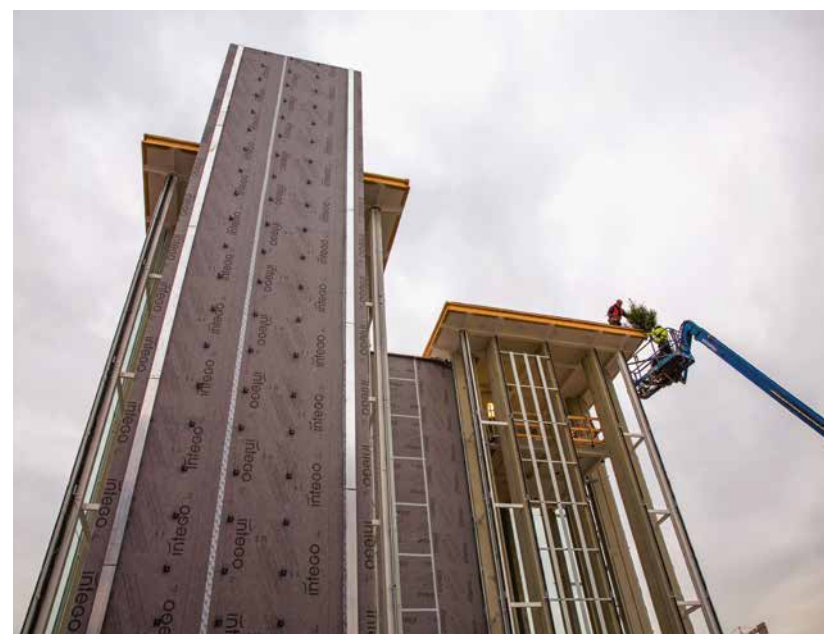
RHO FIERA EXPO MILANO, PADIGLIONE SVIZZERO, 29.1.2015 Un abete sul tetto delle torri per festeggiare la fine della costruzione Richtfest um den Abschluss der Bauarbeiten zu feiern Le sapin sur le toit des tours pour célébrer la fin des travaux de construction
